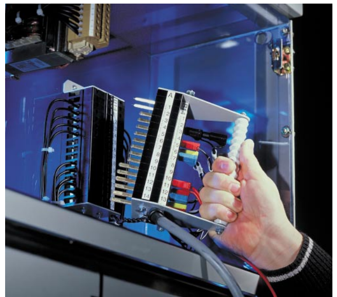
Bild 1. Prüfsteckvorrichtung Typ B14; links Steckdose und rechts Stecker
