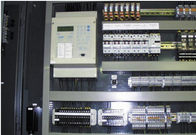
Bild 3. Einsatz einer Prüfsteckdose in der Relaisnische
