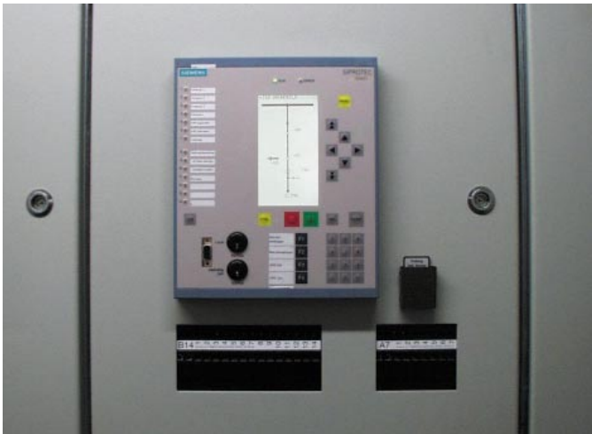
Bild 4. Einbau der Prüfsteckdose in der Nischentür
