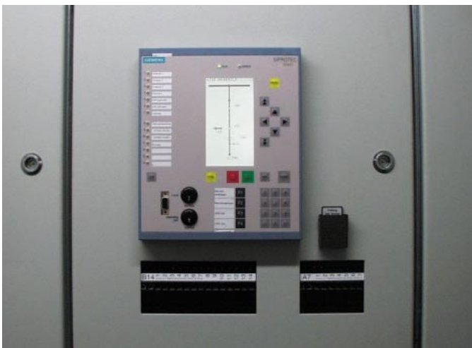
Bild 4. Einbau der Prüfsteckdose in der Nischentür
