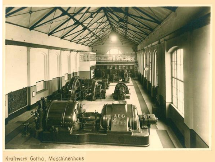
Kraftwerk Gotha, Maschinenhaus
