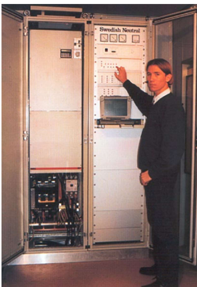
Bild 16: Reststromkompensations- und Erdschlusssuchanlage RCC, von Klaus Winter, Swedish Neutral
