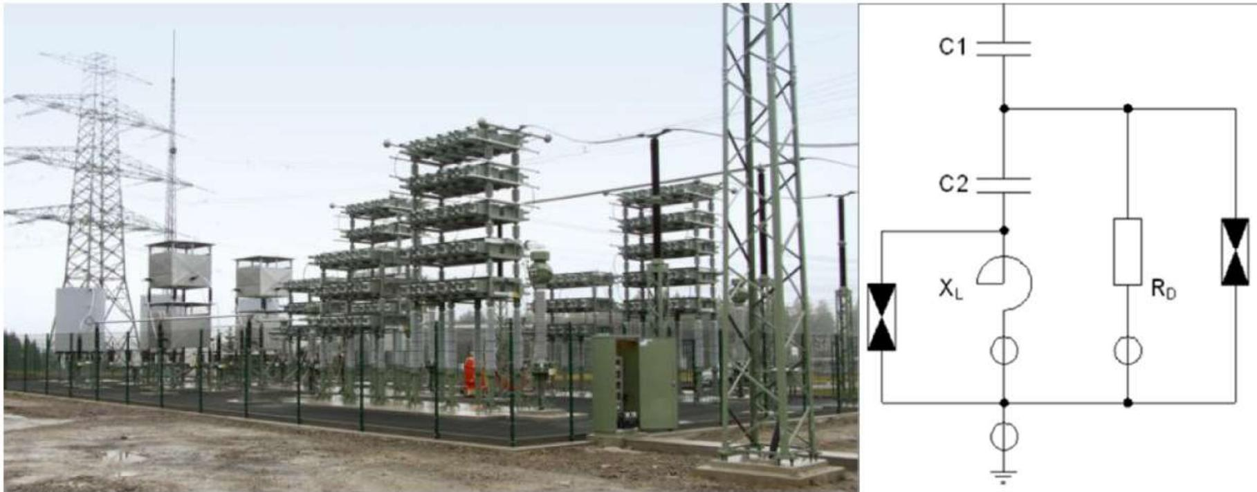
Bild 44: 380-kV-MSCDN 200 Mvar UW Altenfeld (links) und single line (rechts)
