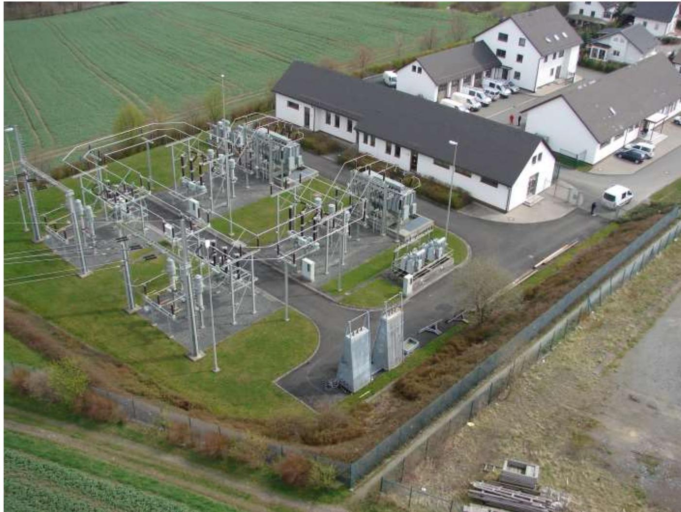
30.09.1993 Inbetriebnahme UW Schleiz, 2x31,5 MVA, OTEV, mit digitalem Schutz, SIEMENS
