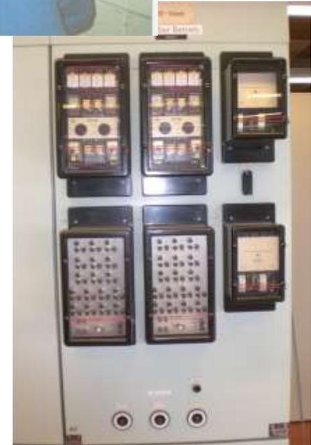
1983 Inbetriebnahme 380/220-kV-UW Vieselbach, mit Hauptschutz RD310 für Leitungen und RQS4T1 und RD110, EAW, für Trafos sowie SS-Schutz R23 R33mod, ZPA, für Dreifach-SS
