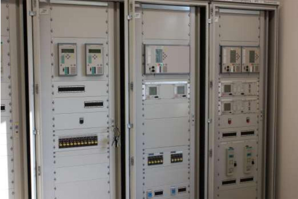
*110-kV-Schutz- und Steuerschränke, li Transformator-Differentialschutz 7UT6 mit UMZ-Schutz 7SJ6, Siemens, Mitte Feldleitgerät, Verstimmungsgradregelung, REG-DP, A. Eberle, und MS-Erdschlusserfassung, EAW UEw01, re Feldleitgeräte, SIEMENS, Spannungsregler, REG-D, A. Eberle, AFE-Relais, 7RW600, Siemens sowie die jeweils zugehörigen Prüfsteckdosen, IPS, SecuControl und Zwischenrelais, 2RH02, EAW*
