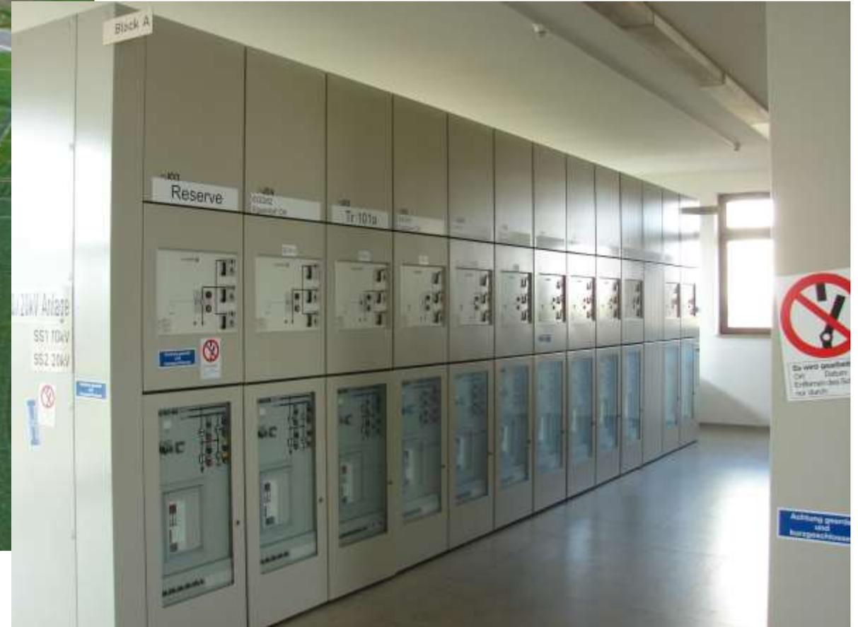
20.02.1997 Inbetriebnahme UW Blankenhain (TEAG) mit digitalem Schutz PD531, PD551, PQ721 und PM481, AEG, Spannungsregler MK30E, MR und Schalfehlerschutz AM1703, SAT
