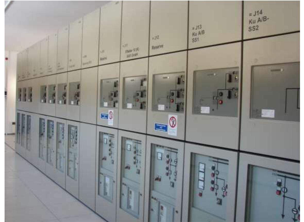
24.08.1995 Inbetriebnahme des UW Mürschnitz (TEAG) mit digitalem Schutzrelais PD531, PD551, PM481 und PQ721, AEG und Schaltfehlerschutz auf der Basis AM1703, SAT
