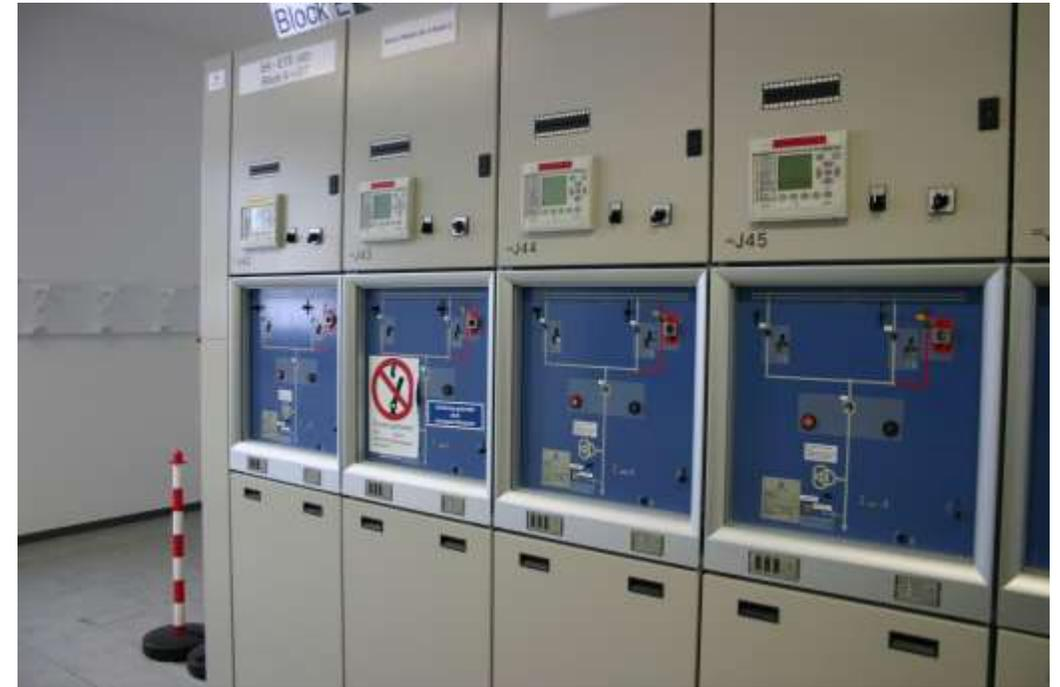
*20-kV-Schaltanlage WSB mit Distanzschutz und Steuerung, P439, AREVA und Prüfsteckdose, IPS, SecuControl*
