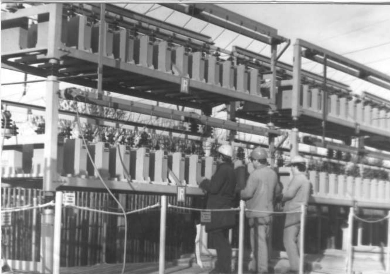
1978 Inbetriebnahme **10-kV-Kondensatorenanlage, 7,2 Mvar, UW Langensalza**,
