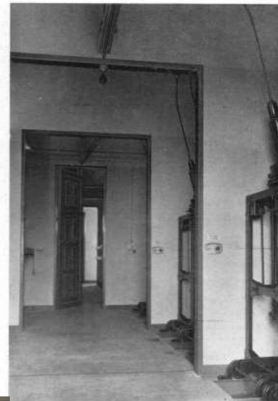
Abb. 49. 50 kV Ölschalterraum im Umspannwerk Weimar. Unterteilung durch Schottentür, Warnlampen auf den Zellenwänden.
