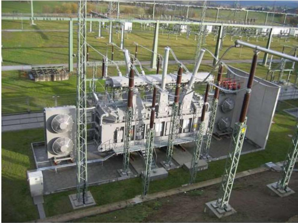
Bild 34: 400-MVA-Transformator 380/220(110) kV im UW Remptendorf
