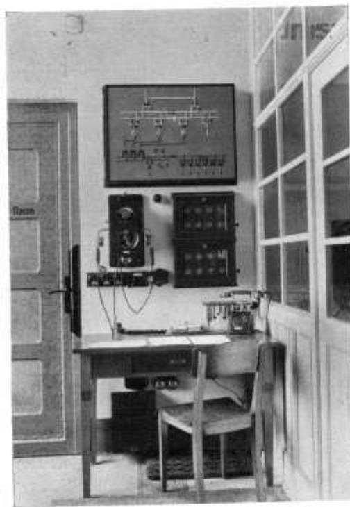
Abb. 47. Warte des Umspannwerkes Weimar mit Blindschaltbild, Gefahrmeldeklappenschrank, Post- und Betriebsfernsprecher.
