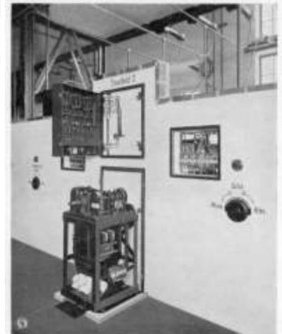
Bild 14. 50 kV-Ölschalterantrieb (Blechhaube abgenommen), Siemens-Westinghouse-Schutz darüber aufgeklappt, Klemmenleistensuche, Trennschalterantrieb mit Stellungslampen.
