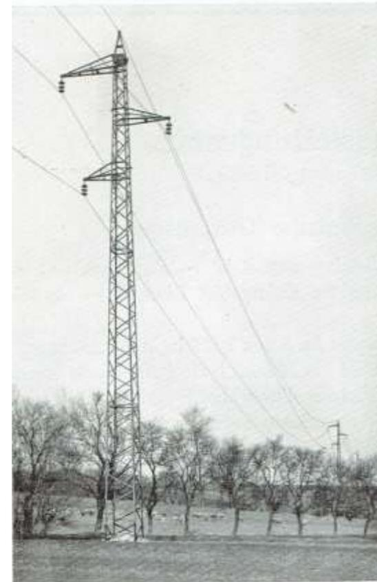
Abb. 17. 50 kV Doppelleitungsmast, vorerst ein Stromkreis ausgebaut.
