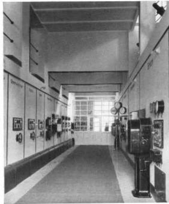
Abb. 42. Bedienungsgang des Umspannwerkes Weimar.
