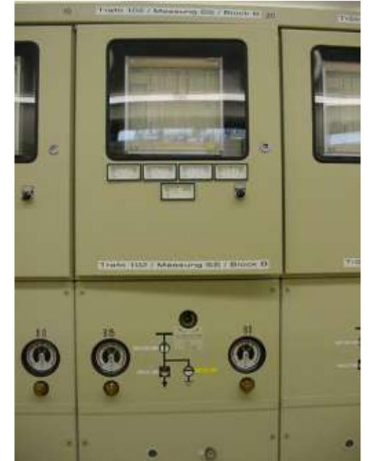
30.03.1992 Inbetriebnahme UW Suhl/West, SEAG, Südthüringer Energieversorgung AG, Meinigen, in MS-Anlage mit digitalem Distanzschutz PD531, AEG und klassischem Schutz in 110-kV-Anlage, EAW
