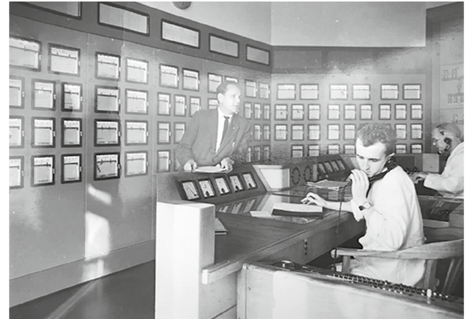
Bild 4: Warte der DO-Elt ca. 1964/65; Berlin-Friedrichsfelde; Rohrdammweg (Leiter der DO-Elt, Herr Wendt; Kraftwerksingenieur Herr Miethke; Netzingenieur Herr Rödíg)
