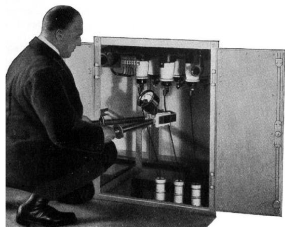
Abb. 5 Strommessung mit Dietze-Anleger
