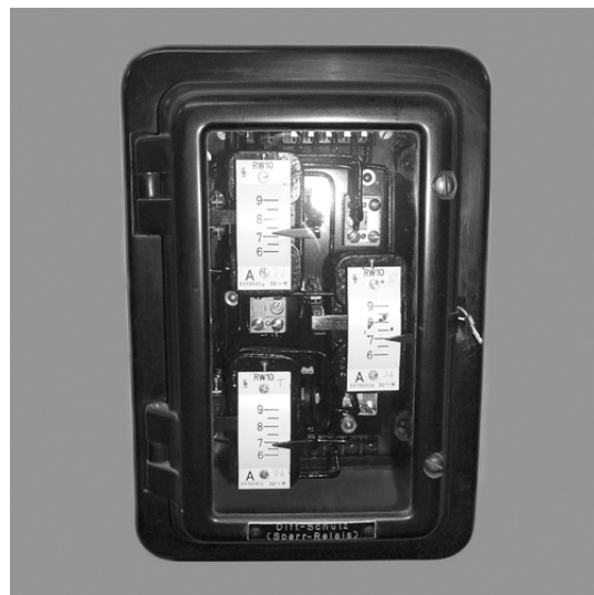
Abb. 18 Differential- (0,5 s) und Überstromschutz (1-10 s) für Regeltransformatoren, Siemensschutz Abb. 19 Stabilisierter Differentialschutz RW10, Siemens
